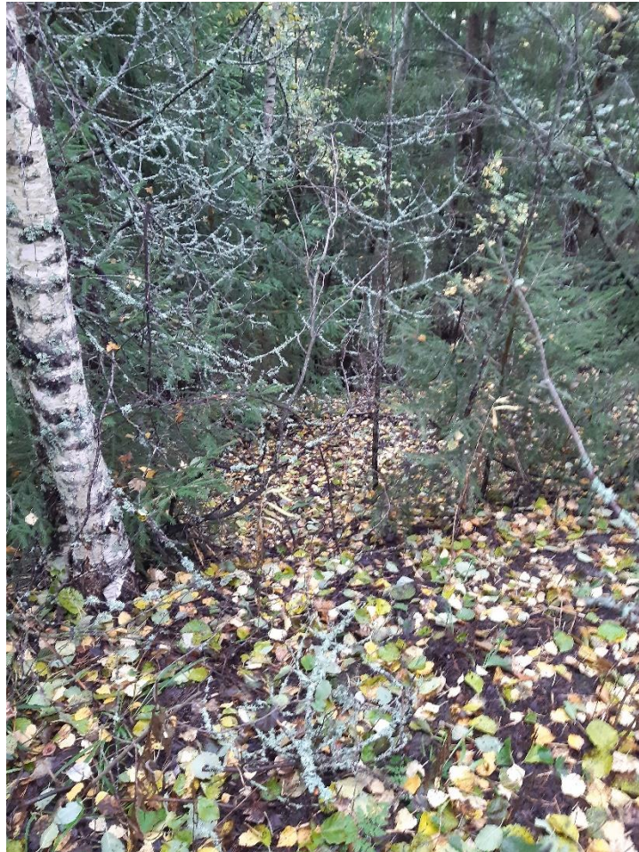
Kuva 1. Tarkastuksella 20.9.2022 otettu kuva patoluiskasta
