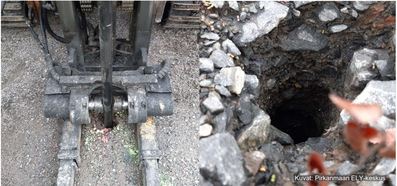
Kuva 4. Injektointien toteutusta Tehostettu biologinen puhdistus (biostimulaatio)
