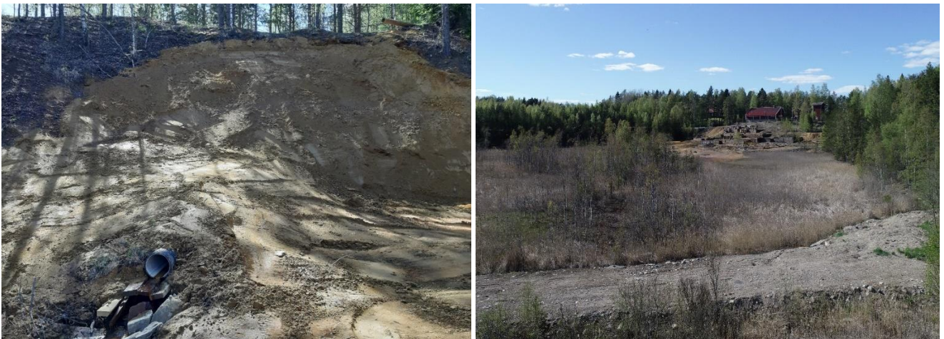
Kuva 7. Tekolammilta purkuputken kunnostustöissä vuonna 2019 ylätason patoa muotoiltiin uudelleen, jolloin rikastushiekkapadon rakennetta häirittiin ja seinämä jyrkkeni entisestään (vasemmanpuolinen kuva © A. Tornivaara). Orijärven rikastamon raunioiden (punakattoisen varastorakennuksen edessä) sekä kuvan etualalla näkyvän padon välissä on alatasen rikastushiekka-alue, jota hallitsee alueen itäosassa kosteikko ja joka jatkuu padon jälkeen Orijärveen asti (oikeanpuolinen dronekuva © T. Lahtinen).
