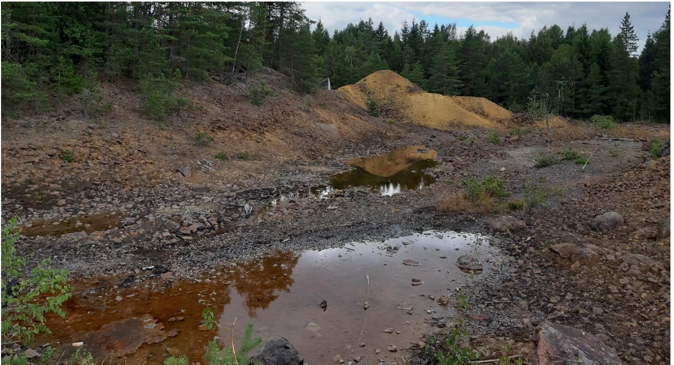
Kuva 44. Orijärven kaivoksen avolouhoksen purkuputkesta ylivuotovedet valuivat ennen putken tukkeutumista sivukivialueelle, purkukohta kuvan etualalla. Alueelle kerääntyy edelleen vesilätäköitä (© A. Tornivaara).
