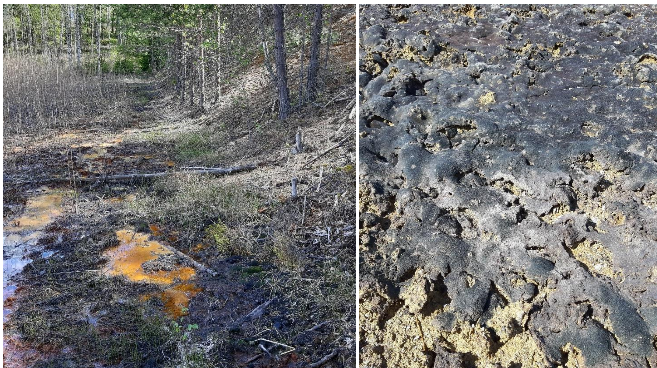
Kuva 12. Vasemmanpuolisessa kuvassa ylätason rikastushiekka-alueen padon alareunasta erottuu muutamia suotovesipisteitä, joiden vesimäärät ovat pieniä, mutta liuenneiden alkuaineiden määrä vesimäärään nähden ilmeinen (saostumien värit). Oikeanpuolisessa kuvassa alatason rikastushiekka alueelle kehittynyt mattamainen orgaaninen kerros, joka vähentää rikastushiekan pölyämistä. Vastaavia sammal/jäköläkerroksia tavataan useilla vanhoilla peittämättömillä rikastushiekka-alueilla ympäri Suomea (© A. Tornivaara).
